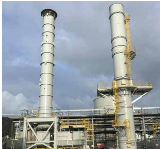
PTT LNG In-Plant Power Generation(Civil & SMP)
