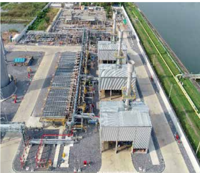
ชื่องาน: PTT Wangnoi Compressor Station
