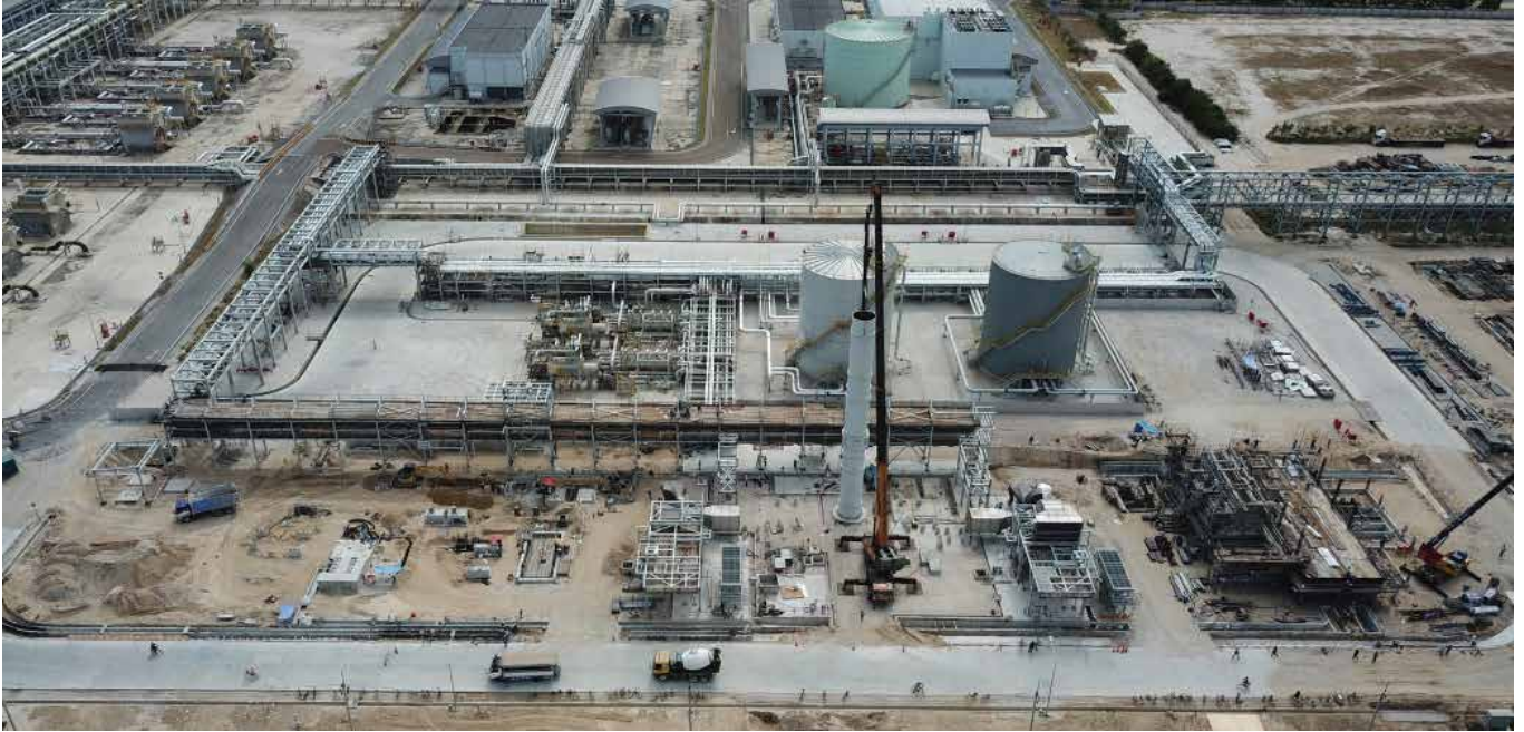
ชื่องาน: PTT LNG Cold Water Facilities
